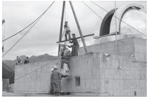
図17 20cm屈折赤道儀架台の搬入(1967年頃)。屋上からは天体ドームのスリットを通して搬入された。
