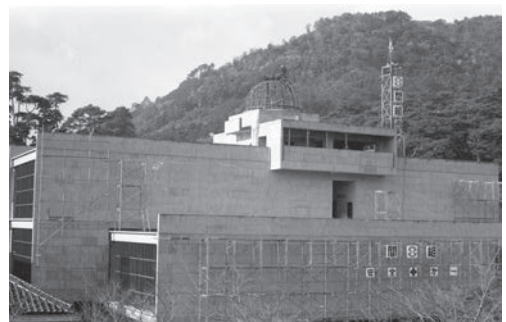
図13 建築中の山口博物館新館(1967年頃)。屋上に工事中の天体ドームが見える。
