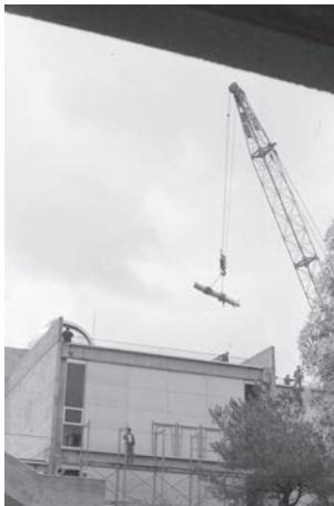
図16 20cm屈折望遠鏡の鏡筒の搬入(1967年頃)。建物北側からクレーンで屋上へ吊り上げられた。
