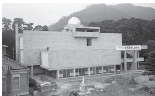
図22 開館目の山口博物館新館。新築当時の外壁はコンクリート打ち放しであった (1967年)。
