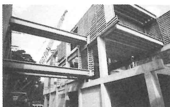
新館建設の様子
