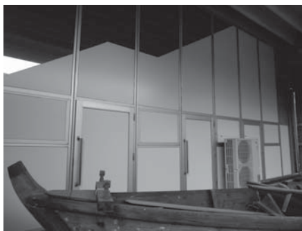
写真6 遮光工事施工後 (2017/11/27)
