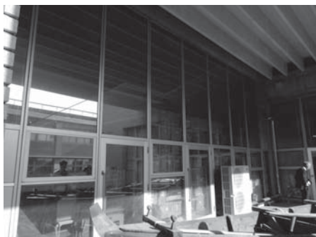
写真5 遮光工事施工前
