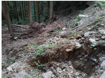
土砂崩れのあった鴻ノ峰の現場
